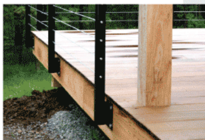
Madera a perfil metálico (Deck)
